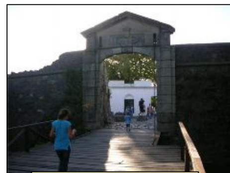
Puerta de la muralla de Colonia de Sacramento, Intendencia de Colonia
