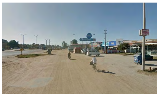
Calle auxiliar previa a las obras de 2017.
