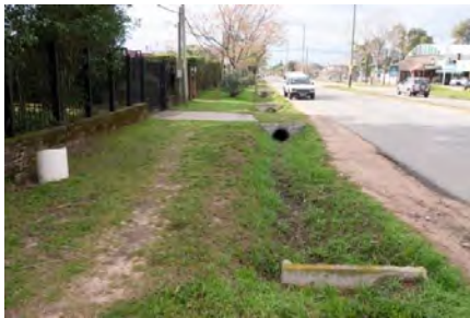
Vereda en tierra y pasto, cunetas y alcantarillas en las entradas de autos.
