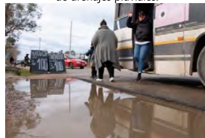
Parada de transporte colectivo sin refugio y vereda inundable.
