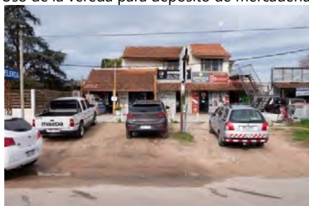
Unificación de las veredas y el retiro frontal sin delimitación de veredas peatonales.
